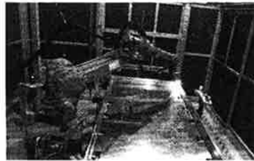
集熱器パイプの溶接工程
